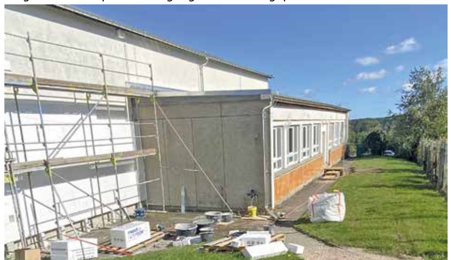
Fassade der Turnhalle. Foto: Gemeinde
