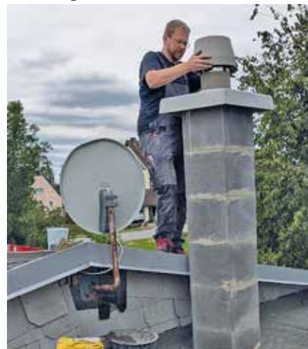
Schornsteinsanierung. Fotos: Höpke
