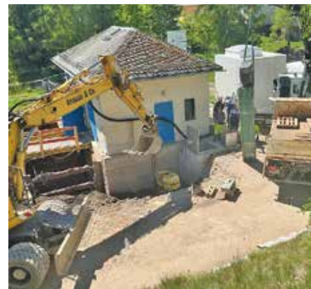
Bauphase. Foto: Gemeindeverwaltung
