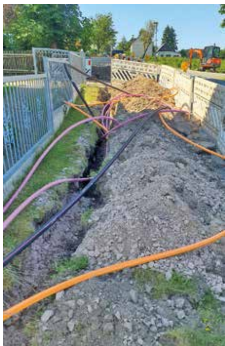
Breitbandausbau. Fotos: Gemeindeverwaltung
