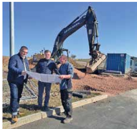
v.l.n.r. BM Viehweg, Projektleiter Uwe Schulz und der Vorarbeiter der Baufirma freuen sich über den Baustart
