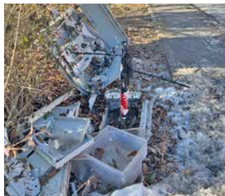
Totalschaden am Elektroverteilerkasten in der Schönheider Straße. Foto: Gemeindeverwaltung
