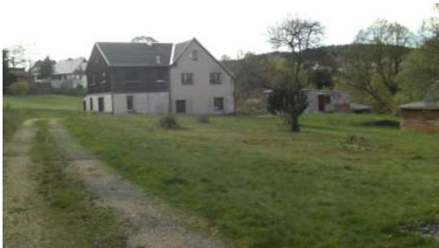
Abbildung 7: Haus Nr. 35, Abriss geplant
