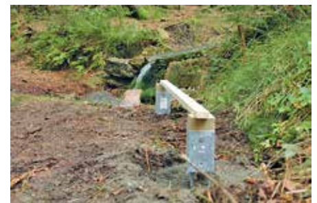
Auf diesen Bodenhülsen werden später die Informationstafeln aufgesteckt. Foto: Gemeinde
