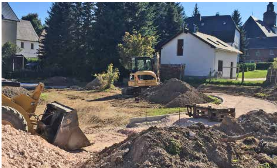
Baustelle „Platz der Generationen“ in Hundshübel. Fotos: Viehweg
